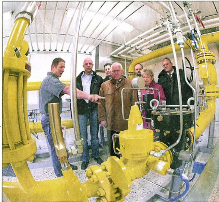
Projektleiter Rudolf Marienfeld erklärt den Kommunalpolitikern die Gasdruckregelstation in Windhagen
